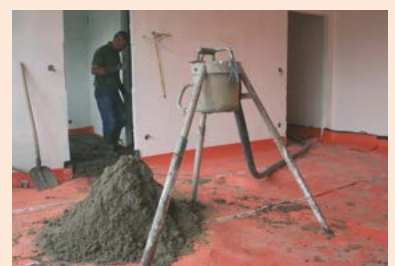
Een chape uitvoeren van \geq 6 \text{ cm} dikte op de Bi+7
