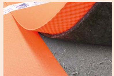
De Bi+7 uitrollen en overlappen met de schuimlaag die uitsteekt
