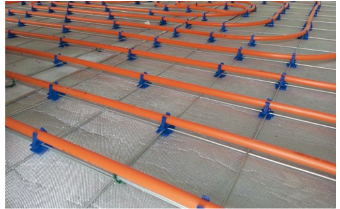
Il est possible d'installer un système de chauffage par le sol directement sur l'insulit Bi+ 9
