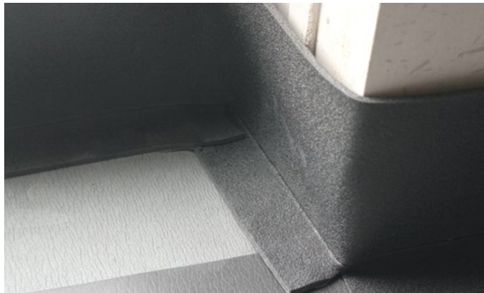
Remonter la bande périphérique Lfoam 18 contre le mur
