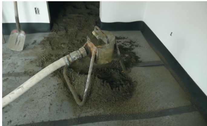
Réaliser une chape renforcée de \pm 8 cm d'épaisseur sur le Bi+20
