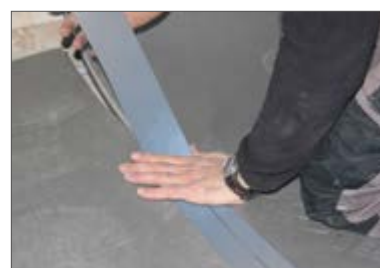
Assurer l'étanchéité avec le StickelTape fourni
