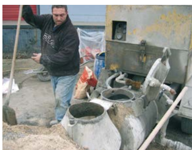
Gemakkelijke mengeling in 5 minuten in de chapepomp
