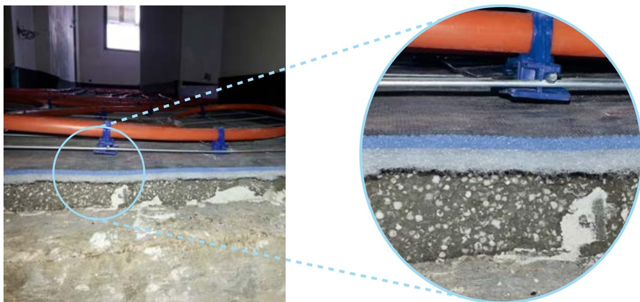
*Exemple de mise en œuvre permettant de répondre aux normes thermiques et acoustiques : insulit Bi+9 posé sur une préchape thermique avec billes de polystyrène.*
