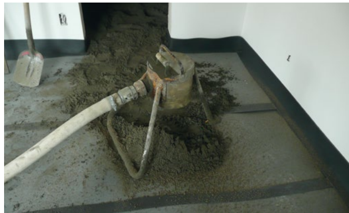
Versterkte chape gieten met een dikte van \pm 8 cm op insulit Bi+20
