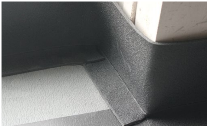
Verbinding tussen de muur en de insulit Bi+20 verwezenlijken met Lfoam 18 randstrook
