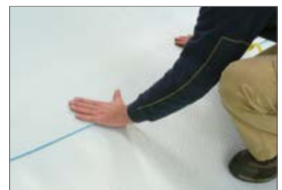
(3) Een goede afdichting van de overlapping verzekeren
