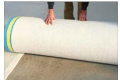
(1) Een overlapping uitvoeren op de aangrenzende band
