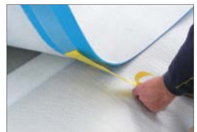
(2) De beschermstrip van de zelfklevende band verwijderen
