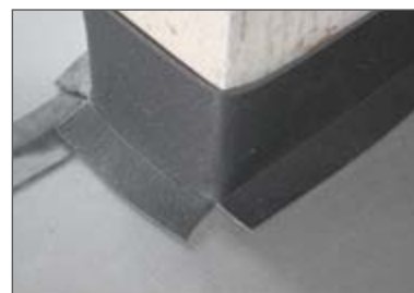
Verbinding tussen de muur en de insulit Bi+20 verwezenlijken met Lfoam randstrook
