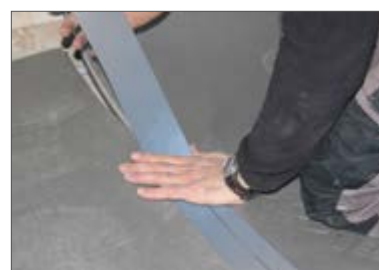
Thermisch afdichten met de meegeleverde StickelTape
