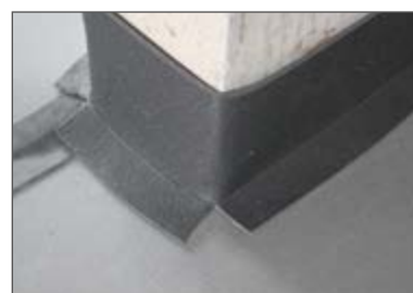
Remonter la bande périphérique Lfoam contre le mur
