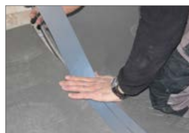
Assurer l'étanchéité avec le StickelTape fourni
