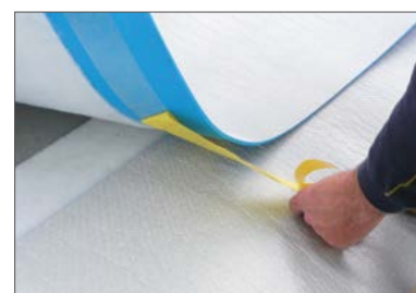
(2) De beschermstrip van de zelfklevende band verwijderen
