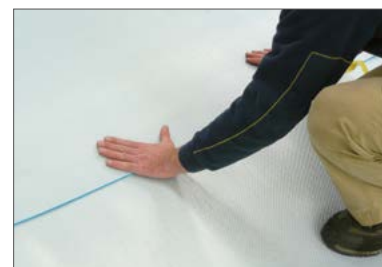
(3) Een goede afdichting van de overlapping verzekeren
