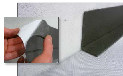
(4) Verbinding tussen de muur en de insulit Bi+9 verwezenlijken met de zelfklevende Lfoam randstrook
