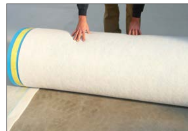
(1) Een overlapping uitvoeren op de aangrenzende band
