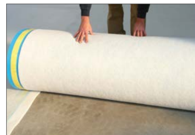
(1) Respecter un recouvrement sur le rouleau adjacent
