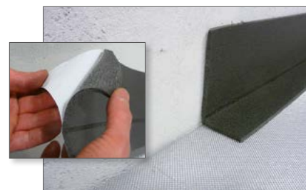
(4) Réaliser la jonction avec le mur grâce à la bande périphérique Lfoam
