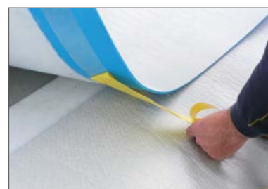
(2) Enlever la bande protectrice du recouvrement autocollant
