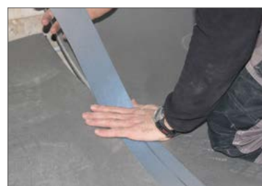
Thermisch afdichten met de meegeleverde StickelTape
