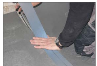
Assurer l'étanchéité avec le StickelTape fourni
