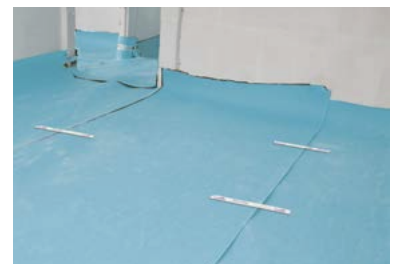
(3) Remonter de \pm 15 cm contre les murs avant de réaliser la chape
