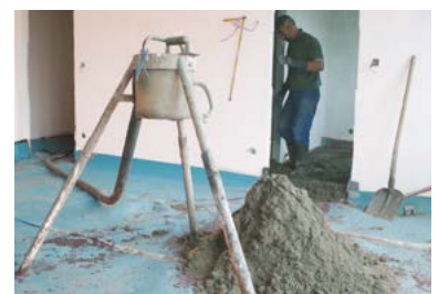
(4) Réaliser une chape de min. 5 cm d'épaisseur sur l'insulit 4+2
