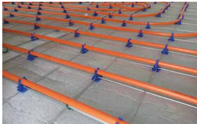
Het is mogelijk om de Insulit Bi+9 te gebruiken in combinatie met vloerverwarming.
