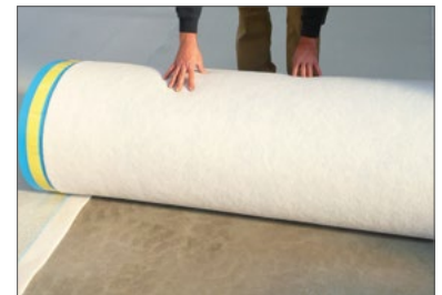
(1) Een overlapping uitvoeren op de aangrenzende band
