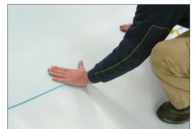
(3) Een goede afdichting van de overlapping verzekeren
