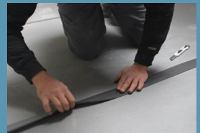
Thermisch afdichten met de meegeleverde Stickelfoam 25/70
