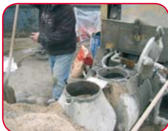
Mélange facile en 5 minutes dans la pompe à chape
